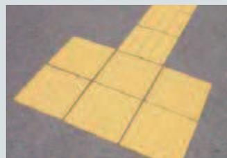
※点字パネル貼り付けの際、商品膨張の可能性があるので、接続部は5mm程度の目地をとってください。
