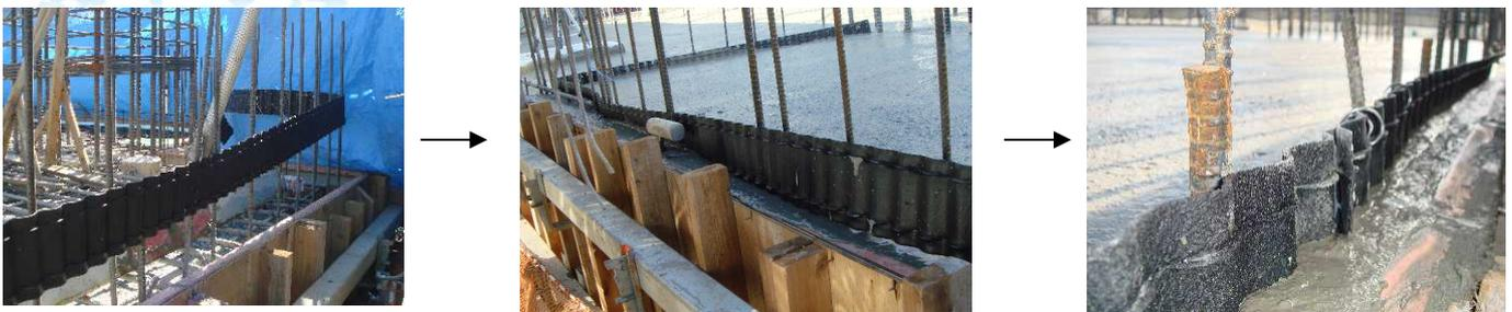
コンクリートを打設した直後に波止めジョニーを押し込みながら取り付けて下さい。
