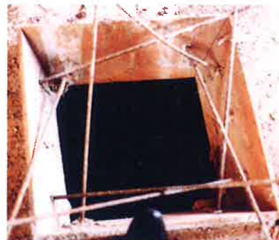
従来工法(箱抜工法)での開口部
