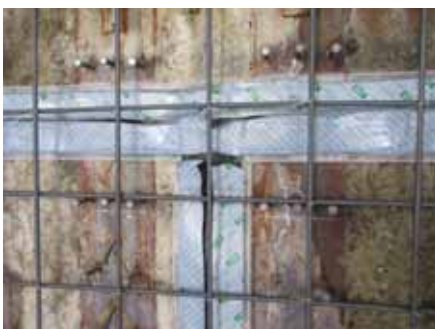
RGS交差部取付状況
