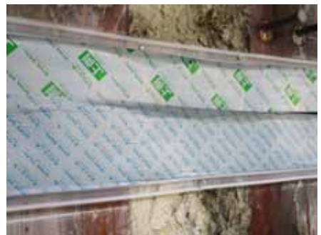
RGS直線部取付状況
