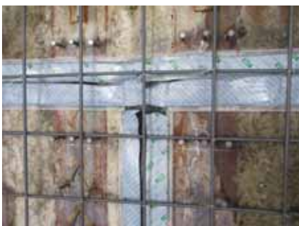
RGS交差部取付状況
