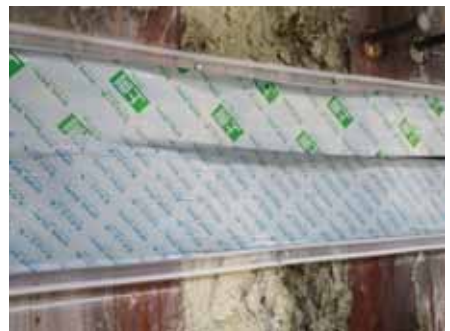
RGS直線部取付状況
