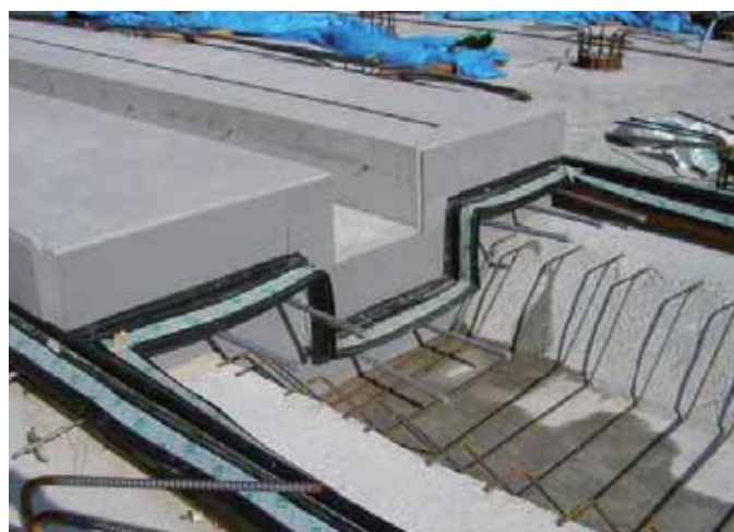
⑧先行型枠脱型完了
