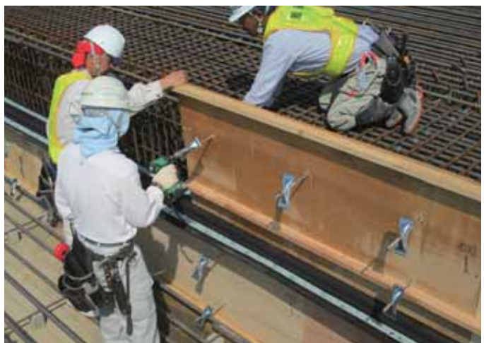
④型枠設置状況
