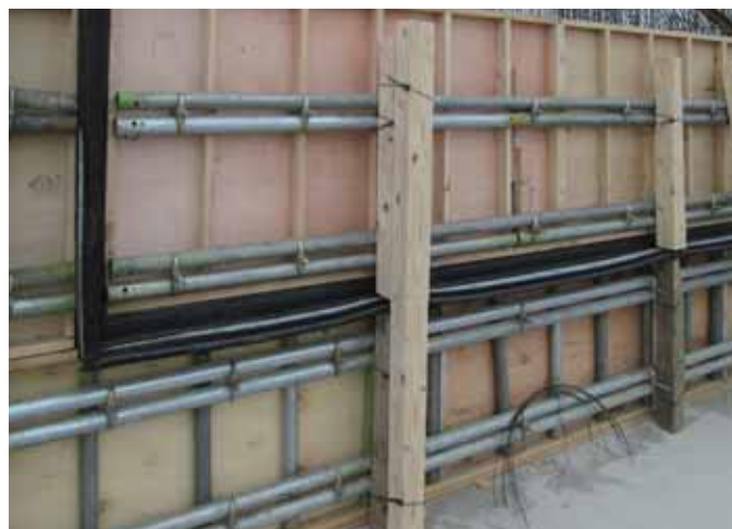
⑥型枠設置完了(コーナー部)
