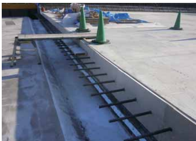
⑦先行型枠脱型完了
