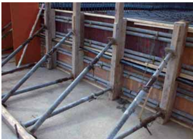
⑤型枠設置完了
