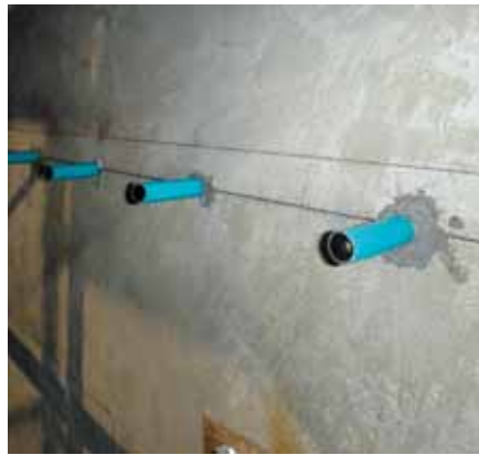
② アンカー設置完了
