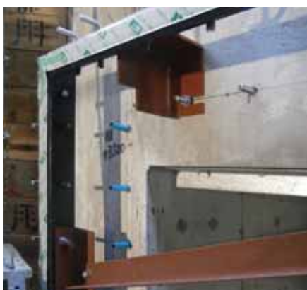
⑨ 上部連結材取付け完了
