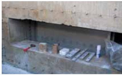
② アンカーボルト設置完了
