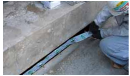
③ シール材(スパンシール)貼付け状況
