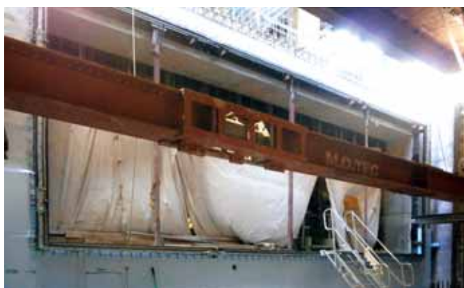
⑦ 先打ち側コンクリート打設完了
