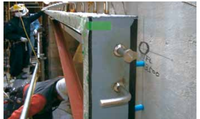
⑧ 鋼製枠位置決め状況
