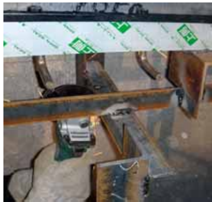
⑤ エキスパンション部架台撤去状況
