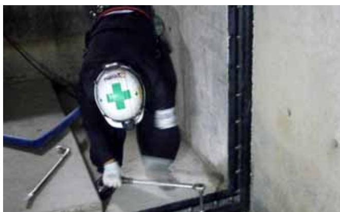
⑧ ゴム取付け状況
