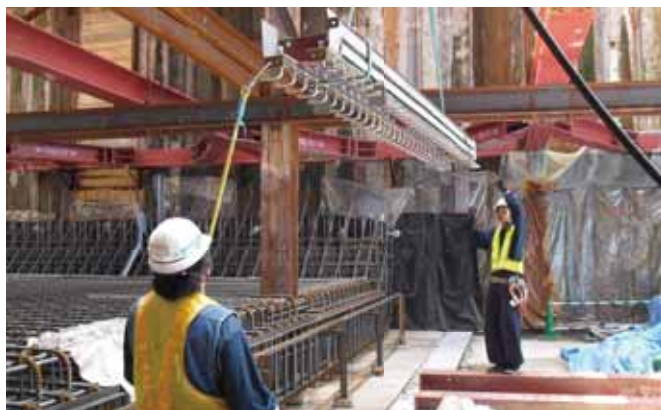
② 鋼製枠設置状況
