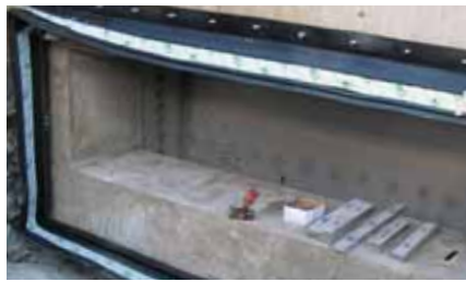
⑤ 伸縮ゴム設置状況
