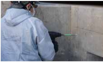
① 削孔状況
