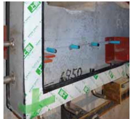
⑥ 下部鋼製枠設置完了
