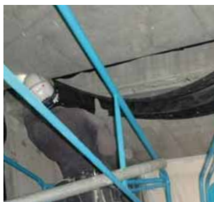
⑩ 伸縮ゴム取付け状況
