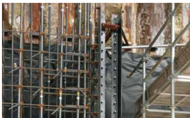
④ 鋼製枠設置完了
