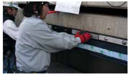
⑥ 押え板取付け状況
