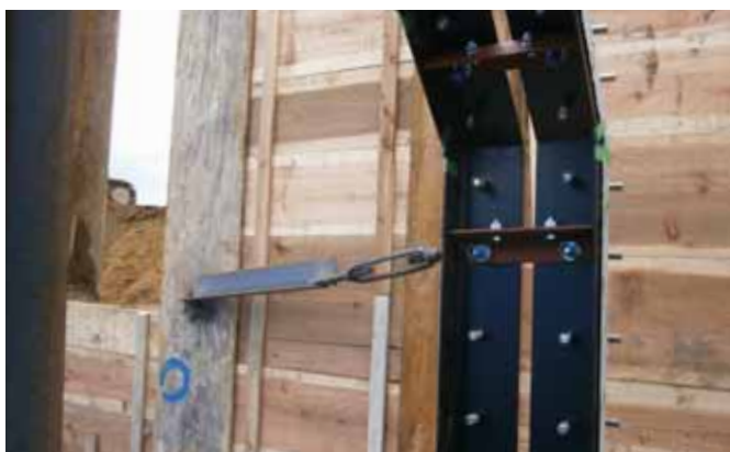
⑤ 控え材設置完了
