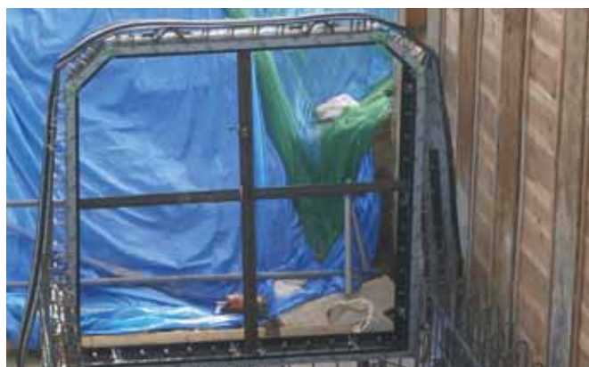
⑥ 鋼製枠設置完了
