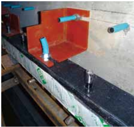
④ 下部連結材取付け完了
