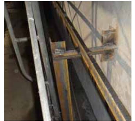
③ 架台設置完了
