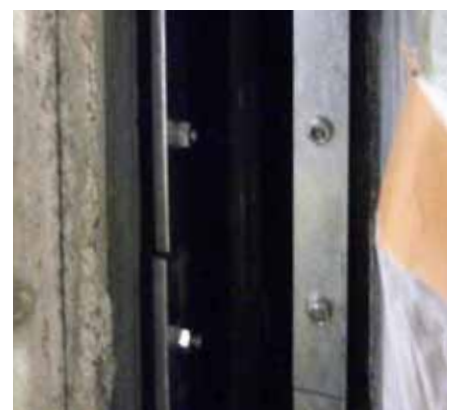
⑪ 伸縮ゴム取付け完了
