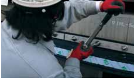
⑦ 締付けトルク確認状況
