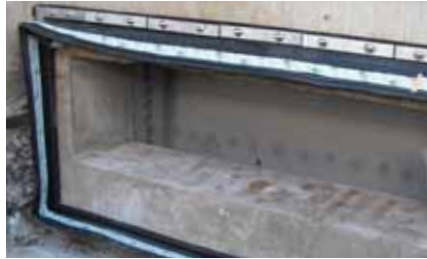
⑧ 伸縮ゴム取付け完了
