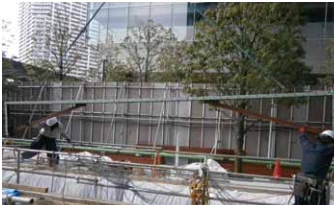
⑦ 上部鋼製枠建込状況
