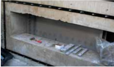
④ シール材(スパンシール)貼付け完了
