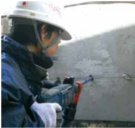
① 削孔状況
