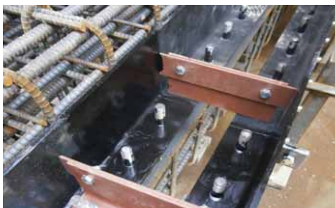
③ 鋼製枠ジョイント部
