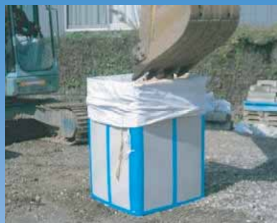
作業員不要で安全対策
