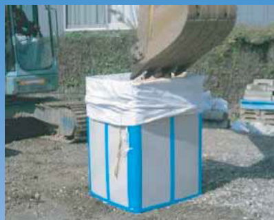
作業員不要で安全対策
